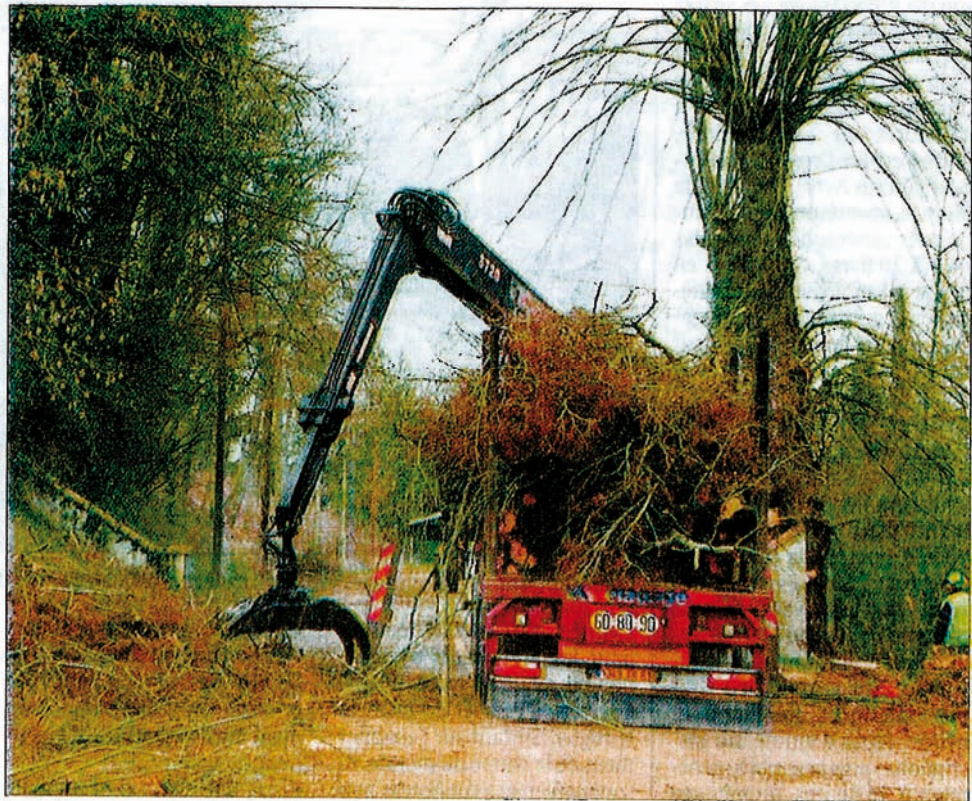
MERCREDI À ÉCLUZELLES: Plusieurs centaines de mètres cubes de bois ont été coupés et transportés jusqu'à Luray pour être transformés en copeaux.
